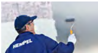
Påfør Hempel's Underwater Primer på overfladen
