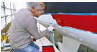
Påføring langs vandlinien
