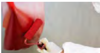
Påføring af bundmaling
