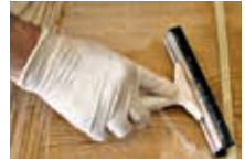
Verschmutztes Wasser entfernen
