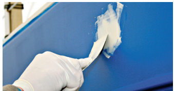
Einzelne Stellen mit Spachtelmesser bearbeiten
