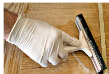
Verschmutztes Wasser entfernen
