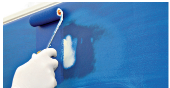
Primer auf einzelne Stellen auftragen
