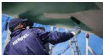
Aplicación del antiincrustante sobre la imprimación o capa puente
