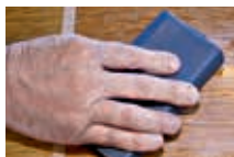
Lijado en seco
