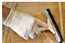
Eliminar agua sucia y restos de lijado
