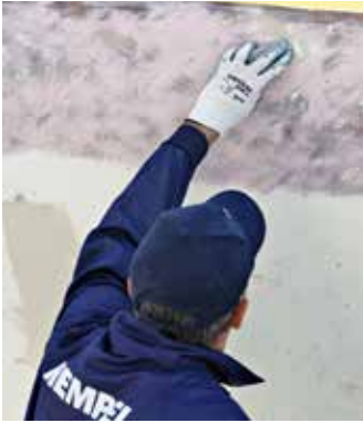
Enmasillado en la línea de flotación
