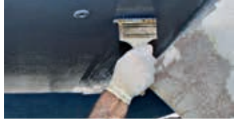
Extender Hempel's High Protect II en direcciones contrarias con brocha (opcional)
