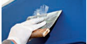
Enmasillado con el uso de una llana
