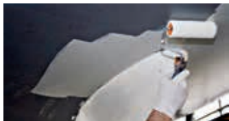
Aplicación del antiincrustante sobre la imprimación.
