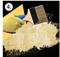
Aplique una capa de Hempel's Silic One sobre la zona dañada, sobre una superficie ligeramente superior a la zona tratada con Hempel's Silic One Tiecoat (aplicar una capa de Silic One a toda la superficie de la obra viva).
