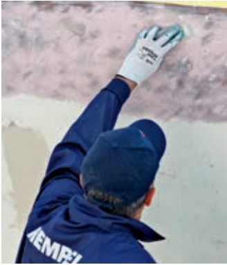
Enmasillado en la línea de flotación
