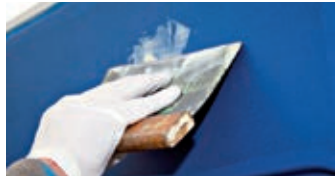
Enmasillado con el uso de una llana
