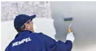
Levitä Hempel's Underwater Primeria esikäsitellylle pinnalle
