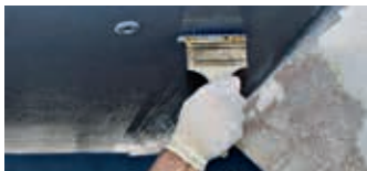
Tasoita Hempel's High Protect II vetämällä vastakkaiseen suuntaan siveltimellä
