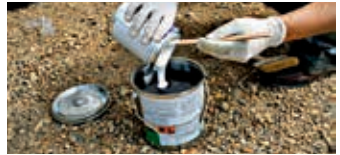
Kaada kovetinta perustaan
