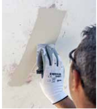
Korjaa pinnan vauriot
