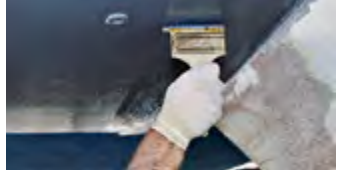
Eftersläta Hempel's High Protect II i andra riktningen med pensel
