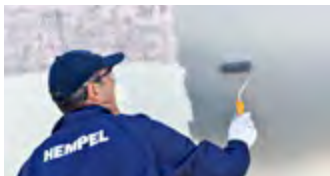
Applicera Hempel's Underwater Primer på den förbehandlade ytan
