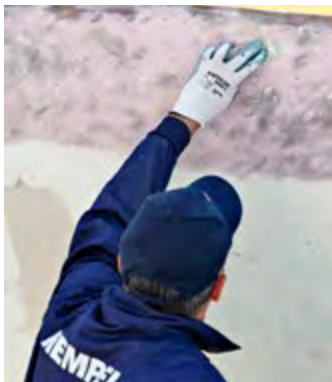
Spackling längs vattenlinjen
