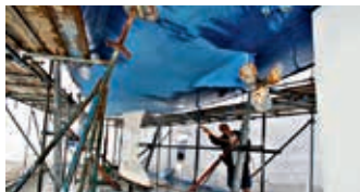
Čista izbrušena površina
