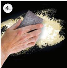
Na oštećenu površinu nanijeti 1 premaz Hempel's Light Primer\* **(Pripremite na "Savjet" s prethodne stranice!)** malo izvan okvira veličine oštećenja.
