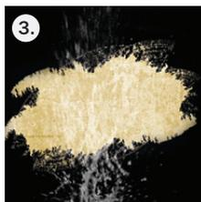
Na očišćenu i suhu oštećenu površinu nanijeti 1 žuti premaz Hempel's Silic One Tiecoat na način da s premazom malo pređete okvire oštećenja.
