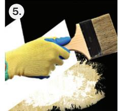
Nakon što se premaz osuši, premaz koji je nanesen uz površinu s popravcima i izvan okvira oštećenja potrebno je odstraniti.
