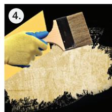
Nanijeti 1 premaz Hempel's Silic One malo izvan okvira površine na koju je nanesen Hempel's Silic One Tiecoat (nanijeti jedan premaz proizvoda Silic One na cijeli podvodni dio).
