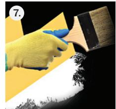
Nanijeti 1 premaz Hempel's Silic One na oštećenu površinu malo izvan okvira površine na koju je nanesen Hempel's Silic One Tiecoat (nanijeti jedan premaz proizvoda Silic One na cijeli podvodni dio).
