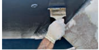
Jevn ut Hempel's High Protect II i motsatt retning med pensel
