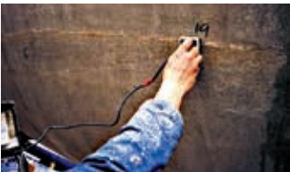
Måling av fuktighet
