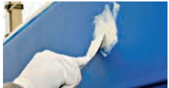
Påføring av sparkel med spatel
