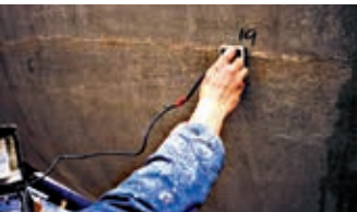
Måling av fuktighet
