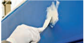
Påføring av sparkel med spatel
