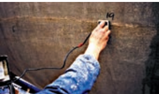
Måling av fuktighet
