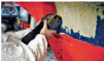
Fjerning av gelcoat med gelcoathøvel
