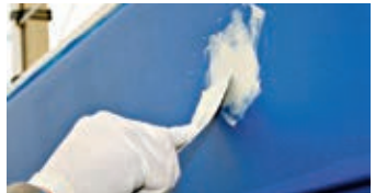
Påføring av sparkel med spatel
