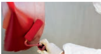
Påføring av bunnstoff
