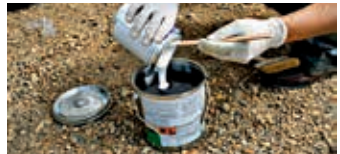
Het uithardingsmiddel in de basis gieten
