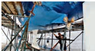
Geschuurd oppervlak reinigen
