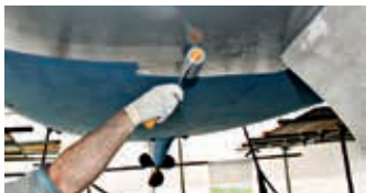
Hempel's High Protect II met verroller opbrengen
