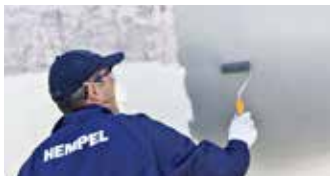
Underwater Primer opbrengen op geprepareerd oppervlak
