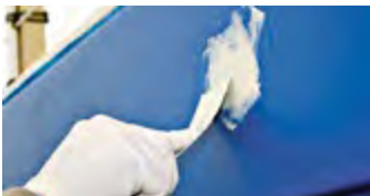
Punktspackla med kittkniv eller smalspackel
