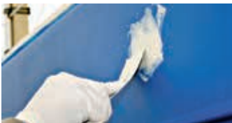
Punktspackla med kittkniv eller smalspackel
